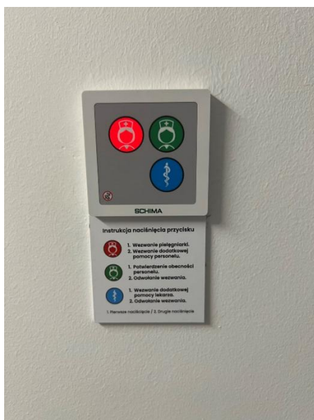
Zdjęcie nr 7: Nowoczesny system wzywania pomocy w toaletach
